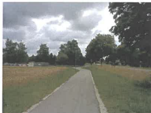
Abb. 7 Fuß- und Radweg südlich der Schwabstadler Straße
