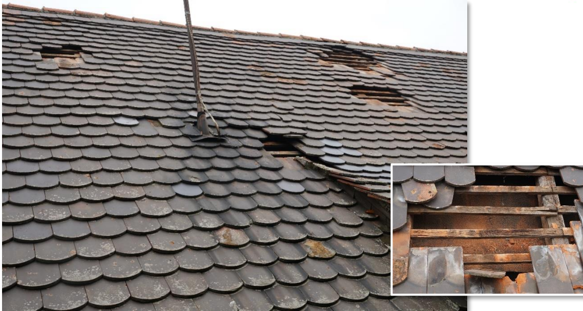
Abb. 3 Öffnung des Dachs an mehreren Stellen, Elias-Holl-Str. 9
