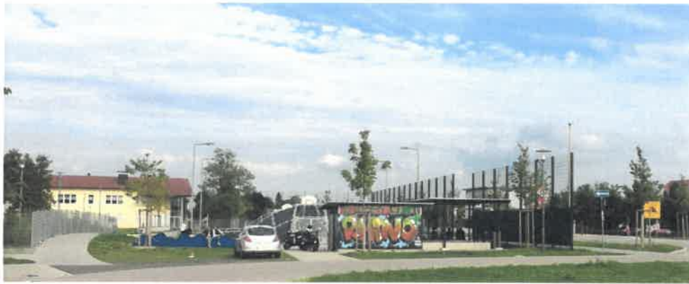
Abb. 7. Fertiggestellter Jugendspielbereich im Sommer 2017
