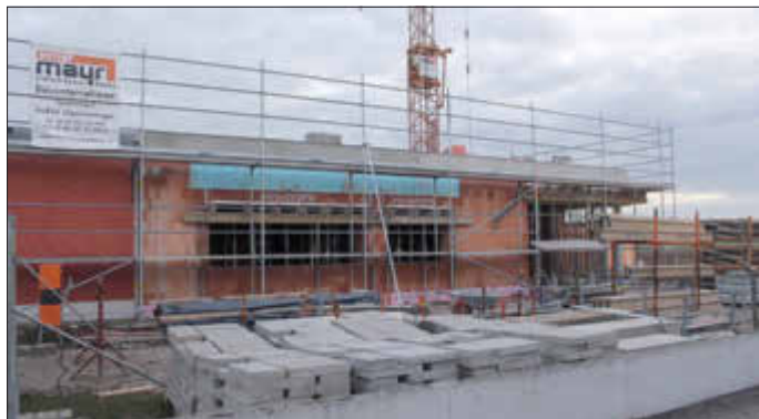
Der Anbau des Franziskus-Kindergartens steht schon im Rohbau. Im Herbst sollen Kinder dort einziehen.
