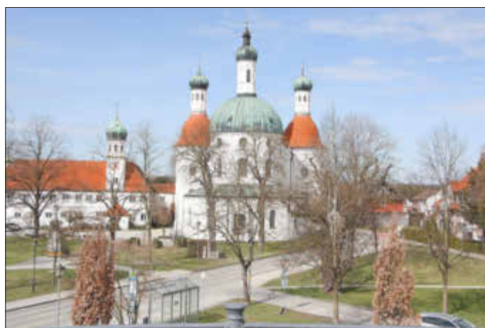
Das Dach der Rotunde an der Klosterkirche muss erneuert werden Foto: Hieronymus Schneider
