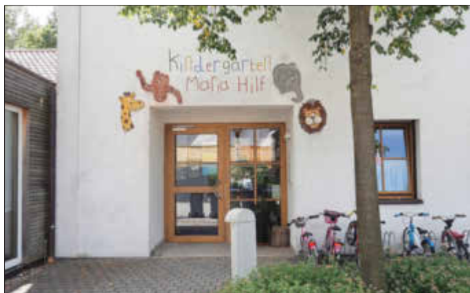
Die Zukunft des Kindergartens Maria Hilf ist wegen hoher Sanierungskosten ungewiss. Foto: Hieronymus Schneider
